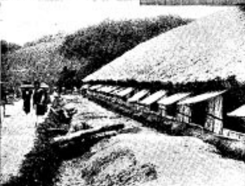
Ett torkskjuv. De å bilden synliga lockorna äro öppna ännå. Man får växelvis vid torkskjuven uppvärmning av skjuven. Härigenom förhindras tobaksbladets mögling.
